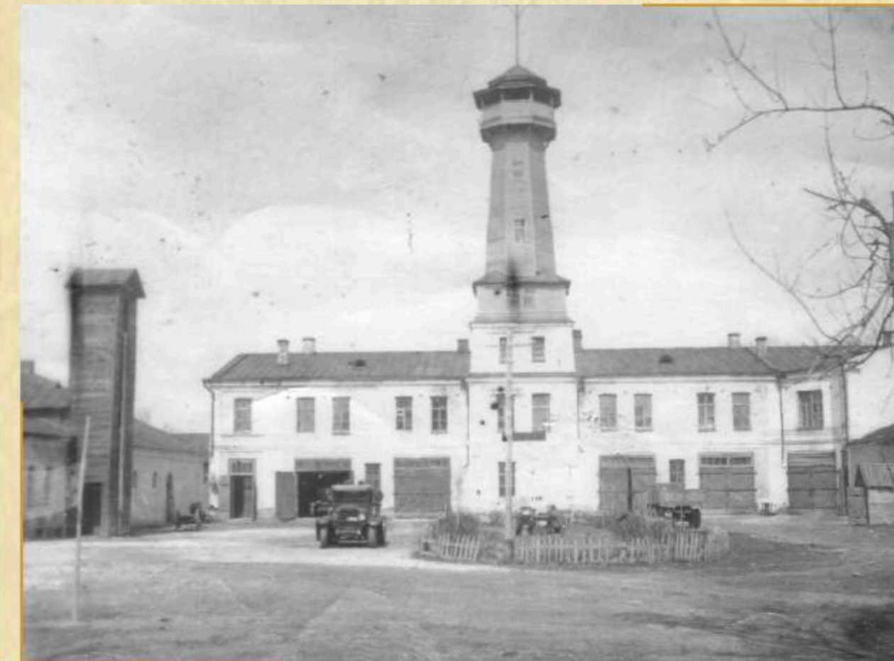
Здание 1-й пожарной части г. Калуги (начало XX века)
